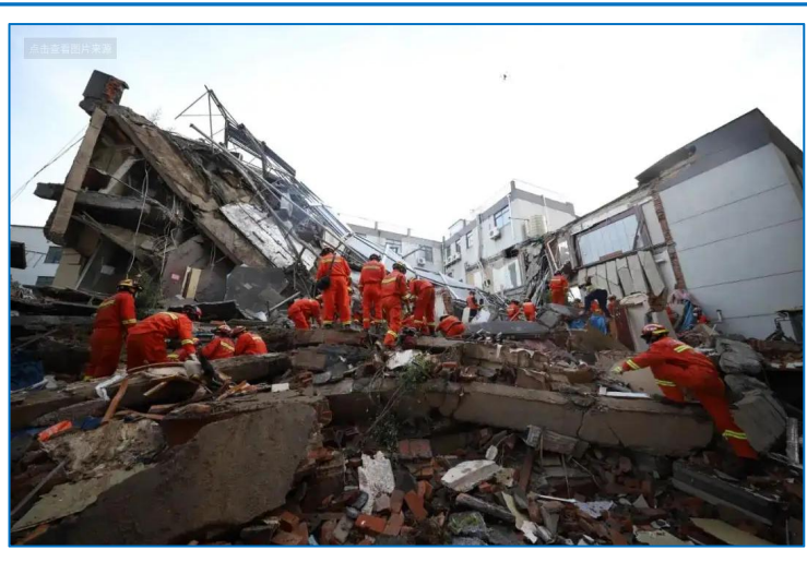
2020年8月29日山西襄汾房屋重大坍塌事故造成 29 人死亡
